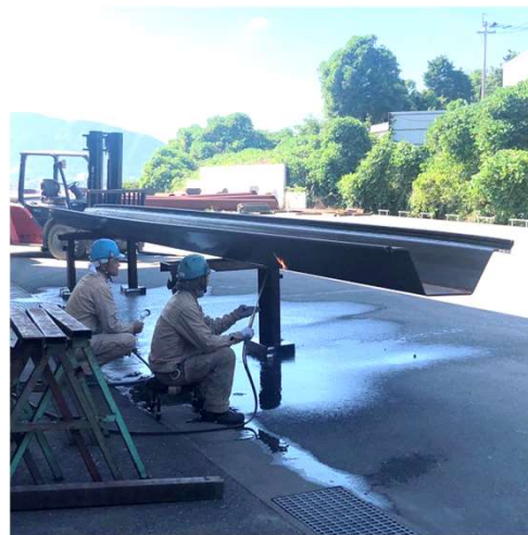
建設資材の加工作業をしています
