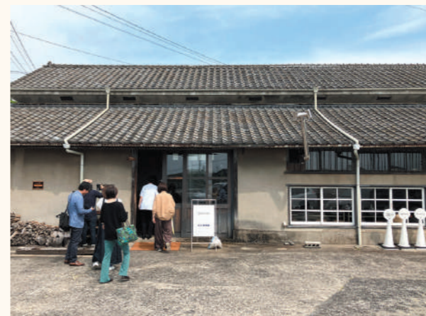
解体が決定していた倉庫を人が集まる場に再生
